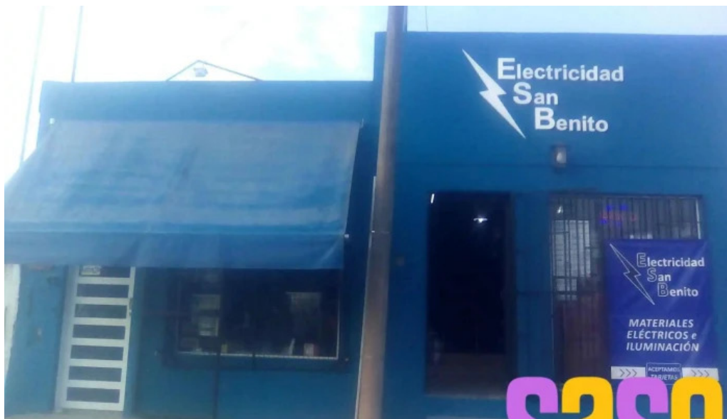
Electricidad san benito exterior
