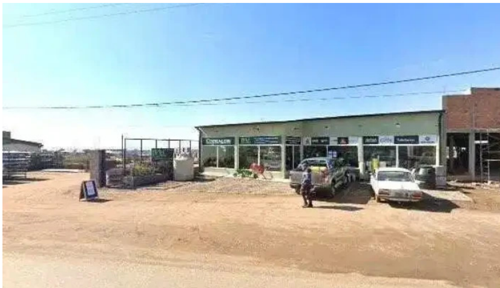
Electrica yacanto telefonodeg
