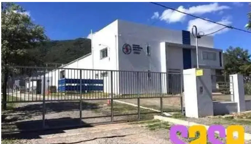
Equipos electricos salta sa zona
