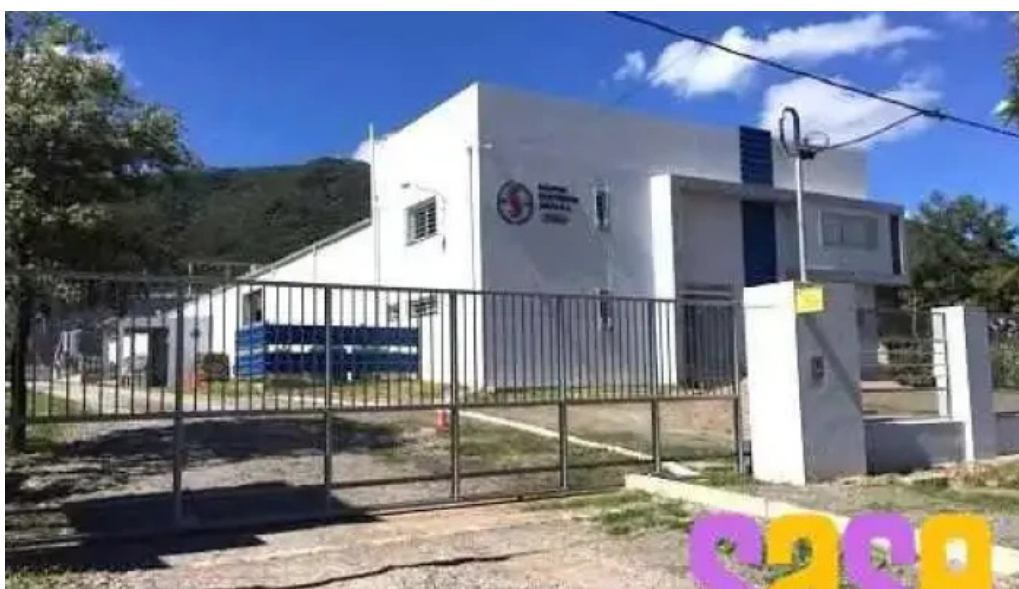
Equipos electricos salta sa salta
