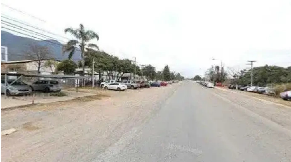
Equipos electricos salta sa zonadeg
