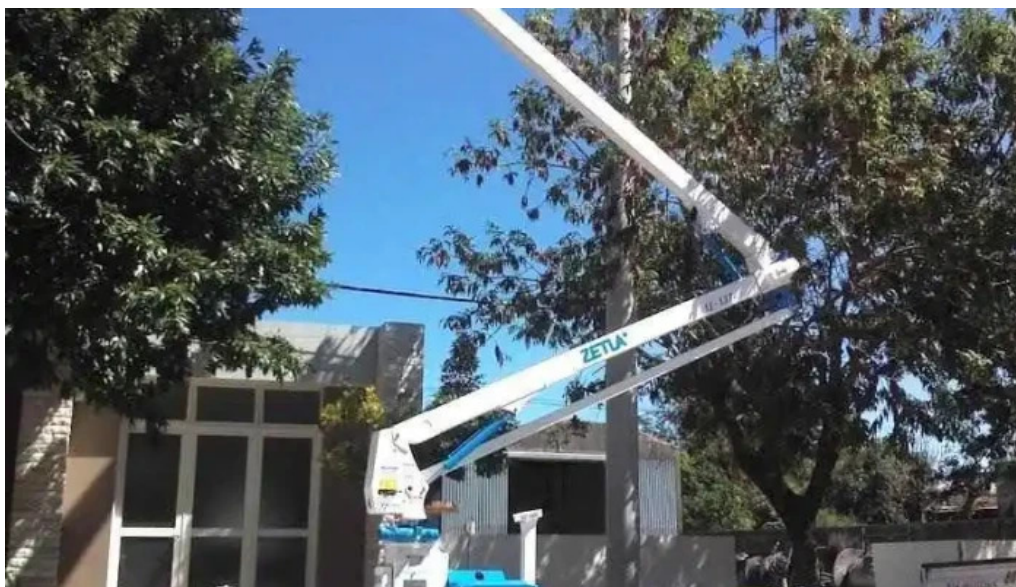
Cooperativa de electricidad cavanagh
