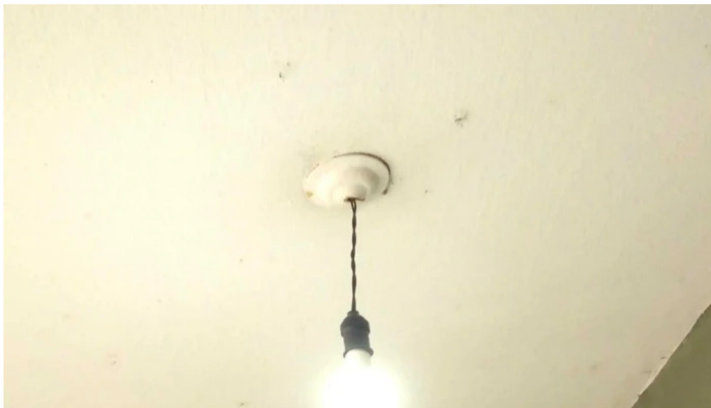
Agrofer electricidad rosario de la frontera
